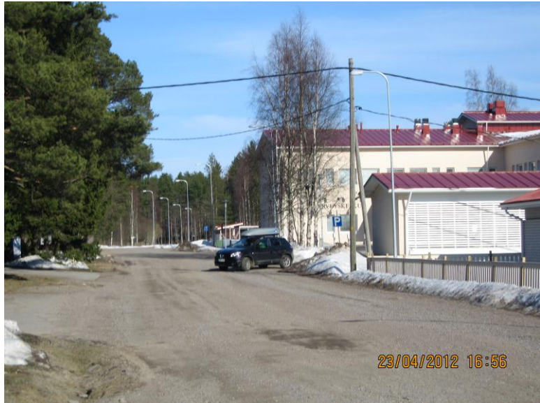
Mäntytie odottaa kesäkauteen ajoitettua päällystämistä.
