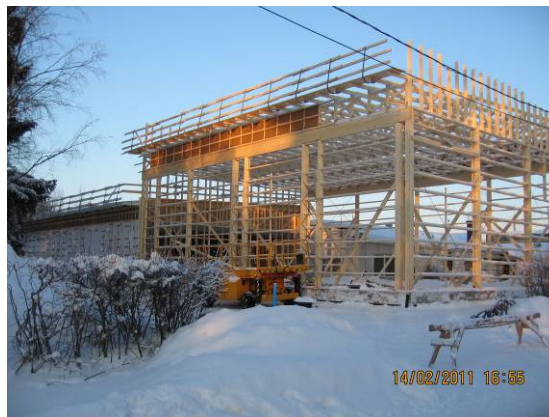
Mäkiosa Oy:n toimitilojen rakennus.
