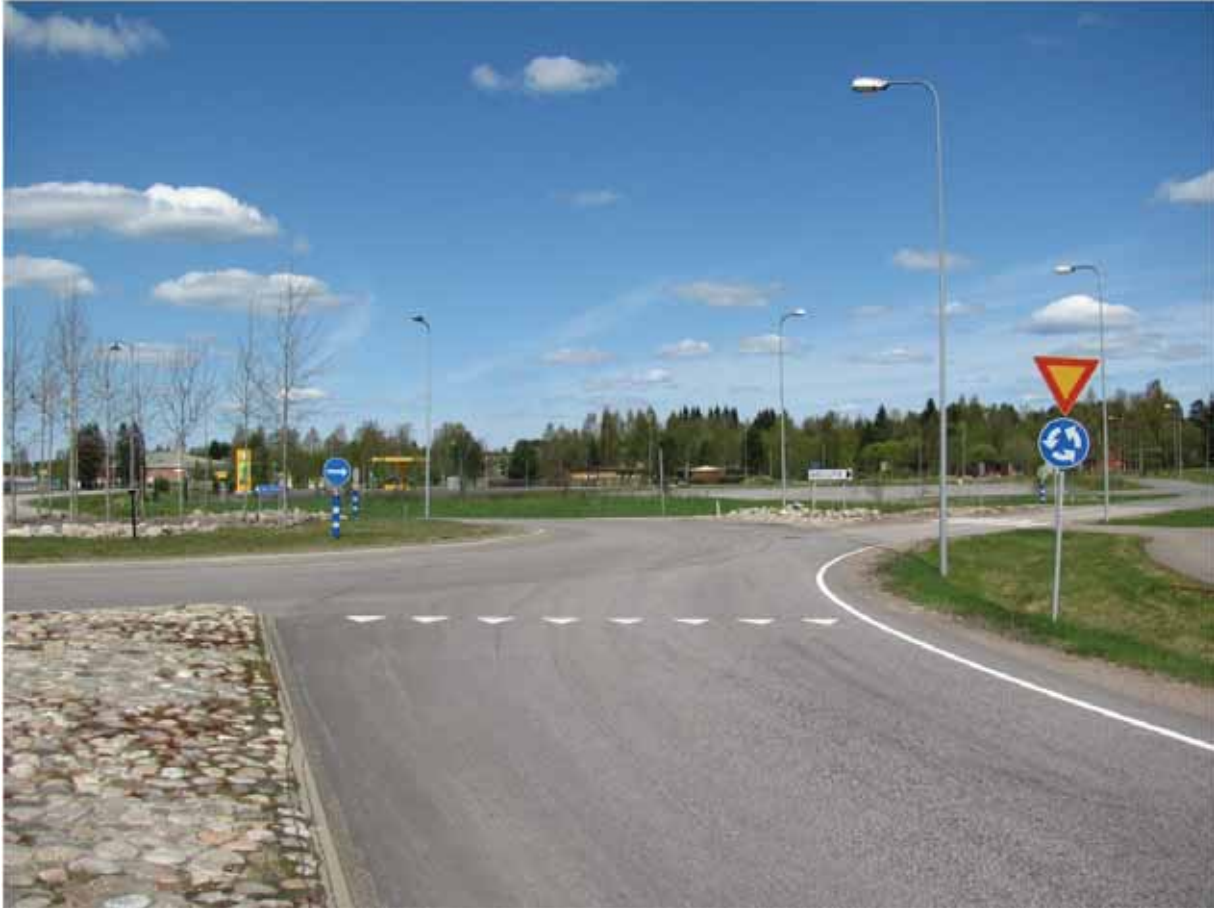
Kuva 23. Kiertoliittymissä on tapahtunut liukkaalla kelillä suistumisia ulkoreunoilla oleviin valaisinpylväisiin.
