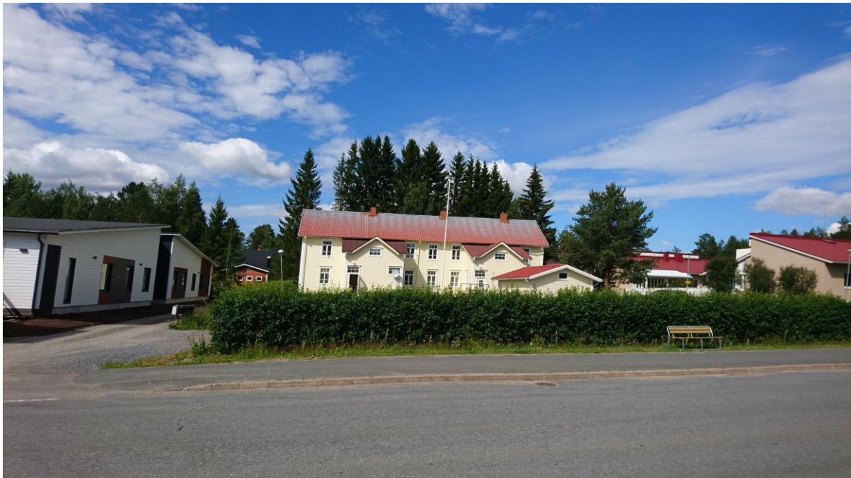
Kuva 6. Nykykaavan tontin 6 rakennuskantaa
