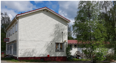
Kuva 5. Kärsämäen Osuusliike länsipuolelta (Ramboll 05/2019).
