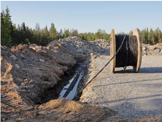
Kuvapari 2-19. Maakaapelit asennetaan ensisijaisesti huoltoteiden yhteyteen (kuvat: Ville Suorsa/FCG).
