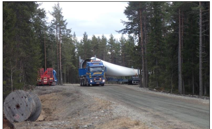
Kuva 2-16. (Vasemmalla) Esimerkki tuulivoimapuiston rakennus- ja huoltotiestä rakentamisaikana. Teitä käytetään muun muassa betonin, soran ja voimaloiden komponenttien kuljetuksiin sekä tuulivoimapuiston käyttövaiheessa huoltoajoihin. Maakaapeli sijoitetaan ojakai- vantoon tien reuna-alueelle. (Oikealla) Tuulivoimalan osia kuljetetaan erikoiskuljetuk- sina. (Kuvat: Ville Suorsa / FCG).
