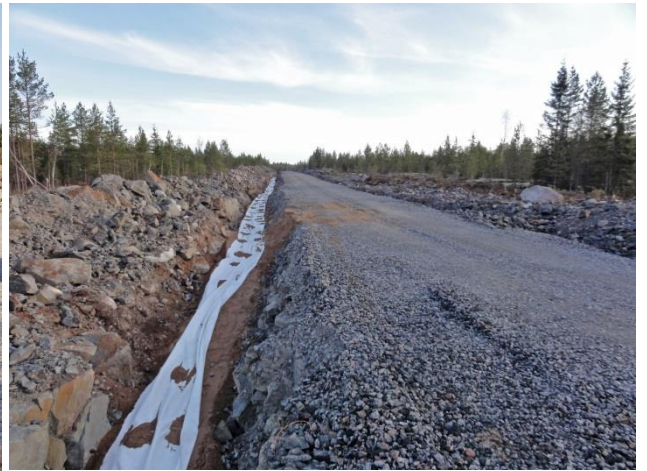
Kuvapari 2-19. Maakaapelit asennetaan ensisijaisesti huoltoteiden yhteyteen (kuvat: Ville Suorsa/FCG).
