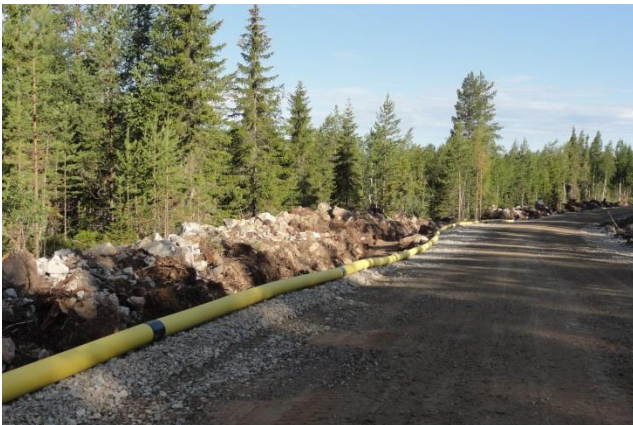
Kuva 2-16. (Vasemmalla) Esimerkki tuulivoimapuiston rakennus- ja huoltotiestä rakentamisaikana. Teitä käytetään muun muassa betonin, soran ja voimaloiden komponenttien kuljetuksiin sekä tuulivoimapuiston käyttövaiheessa huoltoajoihin. Maakaapeli sijoitetaan ojakai- vantoon tien reuna-alueelle. (Oikealla) Tuulivoimalan osia kuljetetaan erikoiskuljetuk- sina. (Kuvat: Ville Suorsa / FCG).
