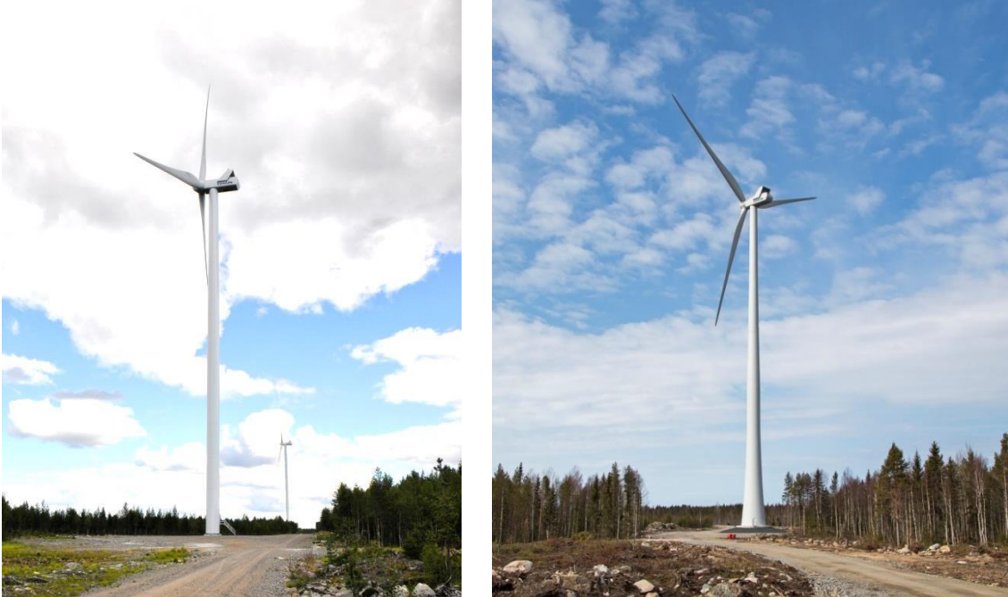
Kuva 2-12. Vasemmalla on esimerkki teräslieriötornista ja oikealla hybriditornista. (Kuvat: Leila Väyrynen ja Ville Suorsa, FCG)
