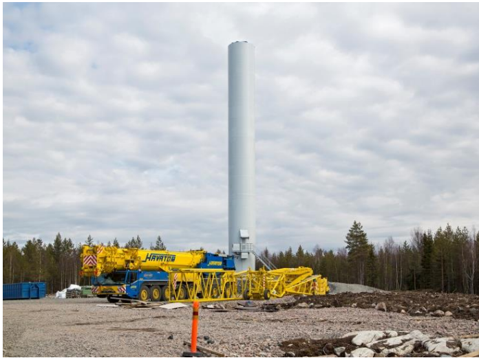
Kuvapari 2-21. Tuulivoimalan kokoamista. (Kuvat: Ville Suorsa, FCG)
