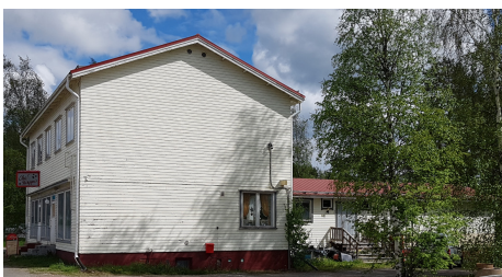
Kuva 5. Kärsämäen Osuusliike länsipuolelta (Ramboll 05/2019).
