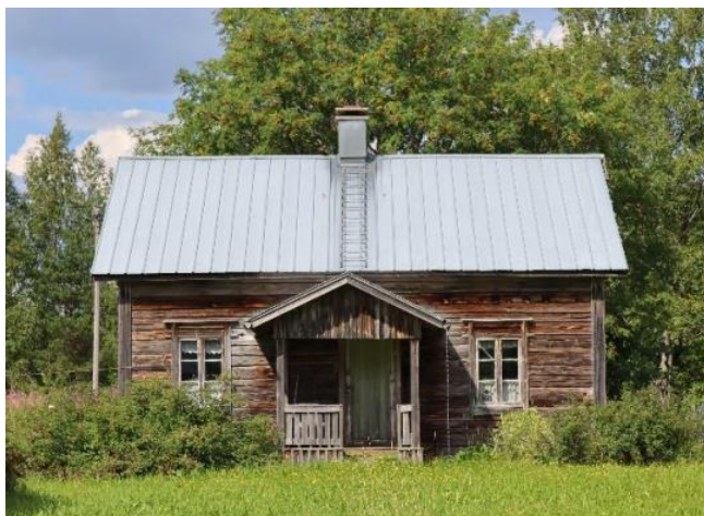
Kuva 20. Pihatuomelan päärakennus (Kuva: FCG 2024)
