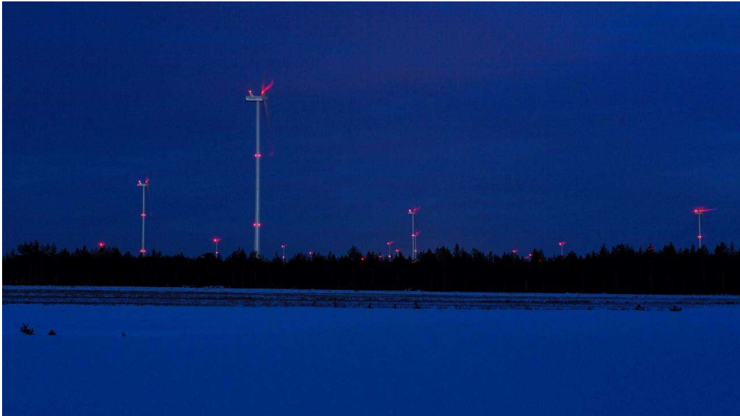
Kuva 81. Kiinteät punaiset lentoestevalot pimeällä. (Kuva: FCG)
