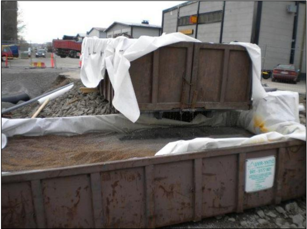
Kuva 13. Esimerkkikuva vaihtolavan sisään rakennetusta suodattimesta. 4
