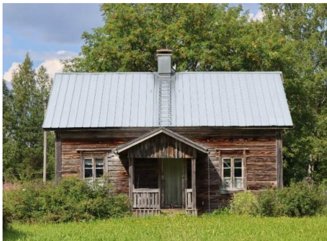
Kuva 23. Pihatuomelan päärakennus (Kuva: FCG 2024)
